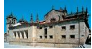
Sacristia, obra do arquitecto João Antunes (1698)
